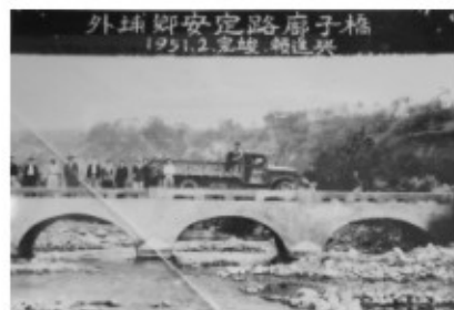
外埔區安定路廊子橋
