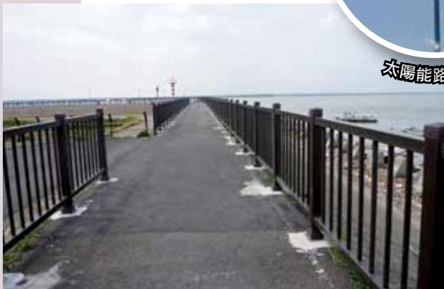
▲麗水漁港西側堤防全景
