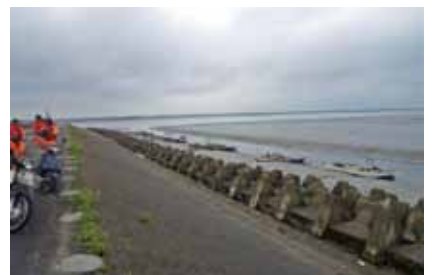
▲本工程施作前
