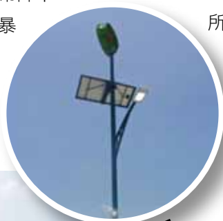
太陽能路燈設置
