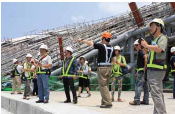
衛武營國家藝術中心自由曲面屋頂鋼結構工程施工
