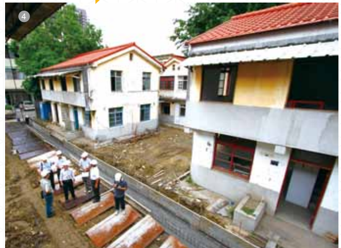
① ② 審計新村基地位置及鄰近區位示意圖 ③ ④ 審計新村基地施作前、施作中
