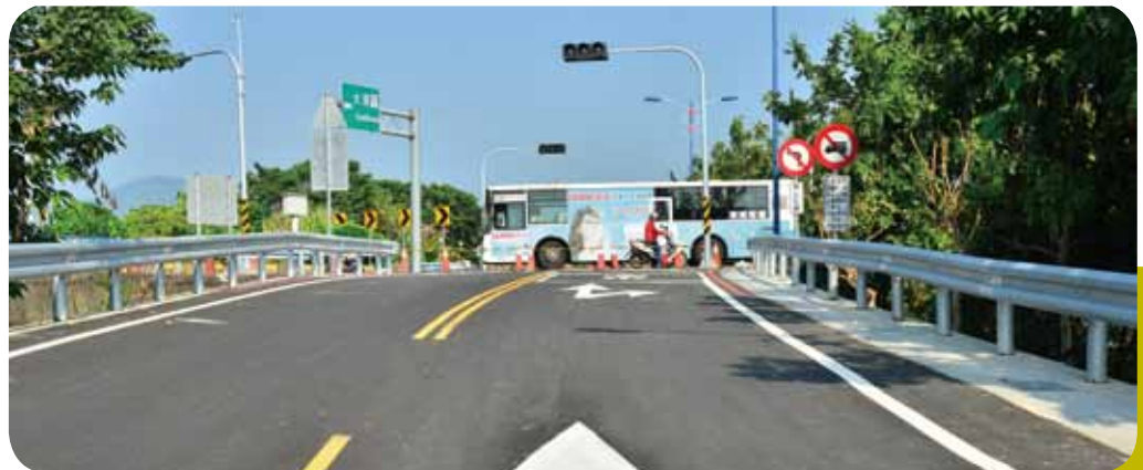
新仁橋引道工程已完工
