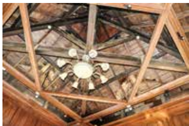
湖心亭屋頂桁架
