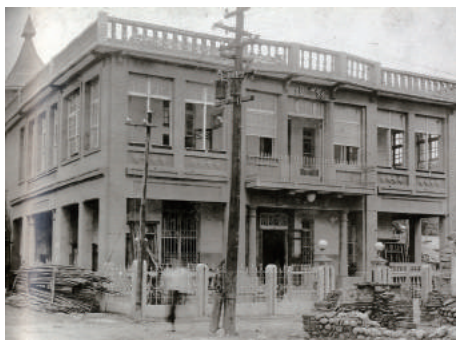
【圖 9-4-10】中興街李宅，左上方樓塔已拆除（牛罵頭文化協進會提供）
