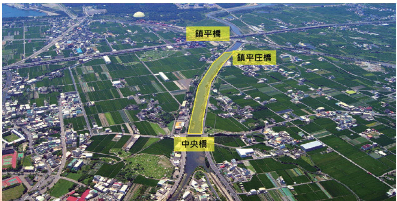
▲清水大排整治工程
