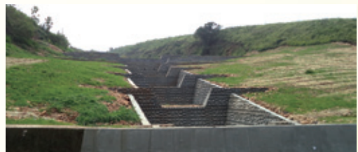
▲鰲峰山公園第一期工程已完工
