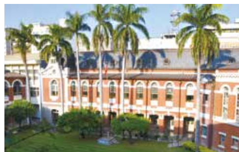
臺中州廳背面紅磚牆、拱窗
