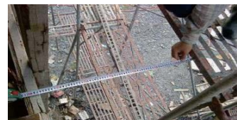
第三層施工架與建築物外模距離量測為72cm
