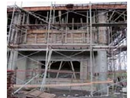
第三層施工架與建築物外模距離量測為72cm
