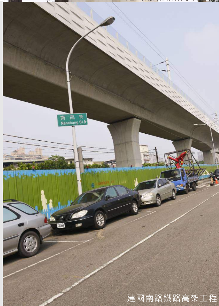
建國南路鐵路高架工程
