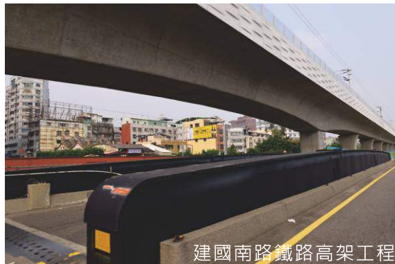
建國南路鐵路高架工程
