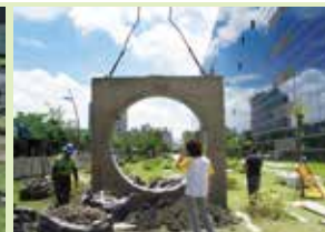
混凝土牆基礎運至現場 後覆土
