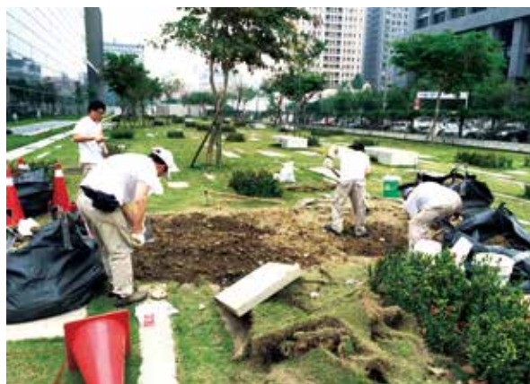
人工向下挖地坪、確立基礎尺寸及相關配線管路無誤
