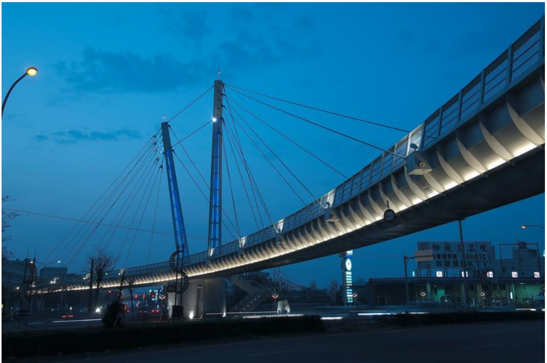
沙鹿之翼(臺中市中棲路三民路路橋)
