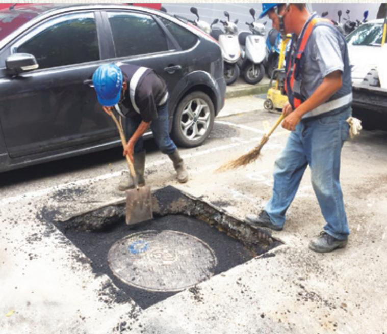
孔蓋下地後，施工人員將周圍填補平整。
