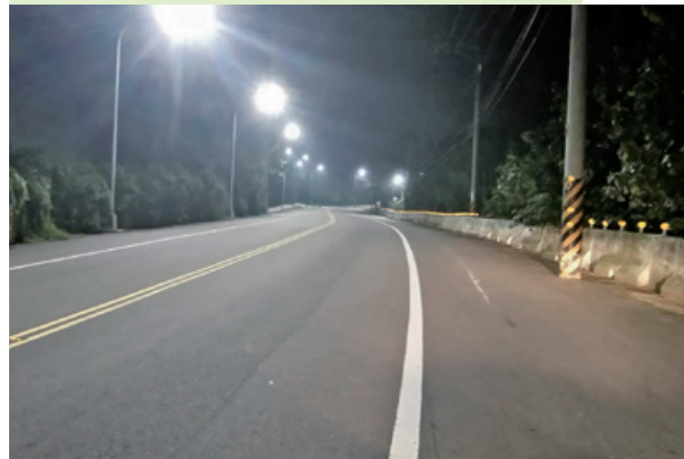
上 施工人員將水銀路燈汰換為 LED 路燈。
