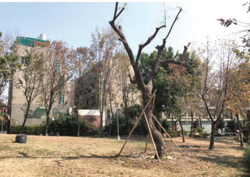
樹木移植完成後，須設立臨時支撐架固定。
