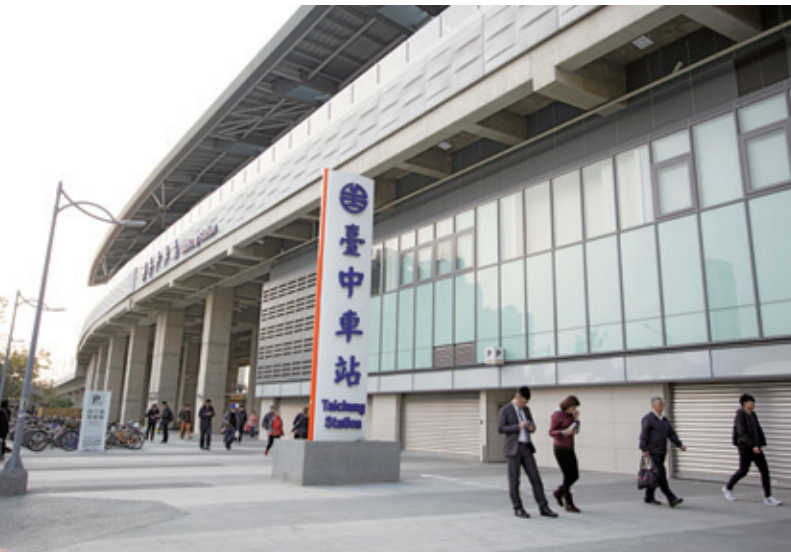
臺中鐵路高架捷運化，是臺中市交通建設的里程碑。
