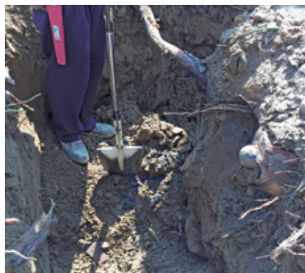
移植樹木時，施工人員進行斷根處理。
