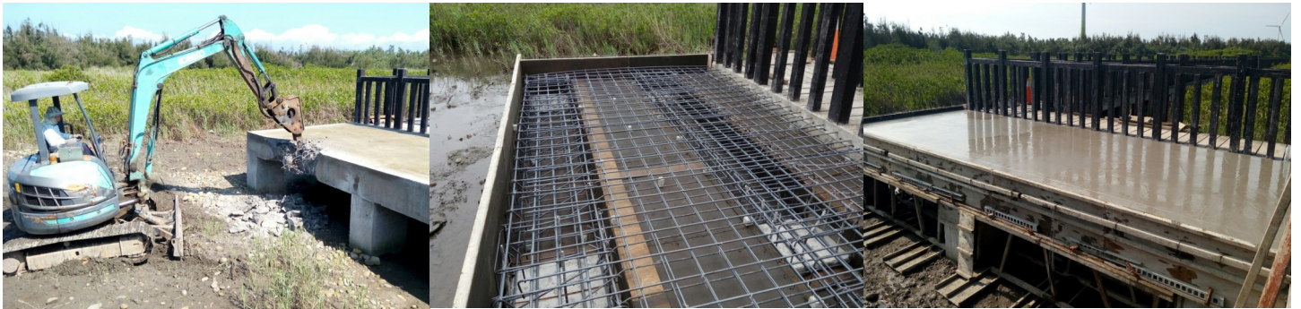
▲公共工程抽驗現場及混凝土強度不足改善情形
