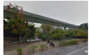
車站以南-園道空間
