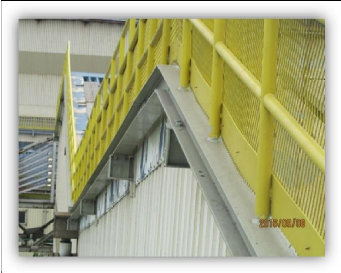
圖 2 山牆欄杆現場栓接代替焊接。
