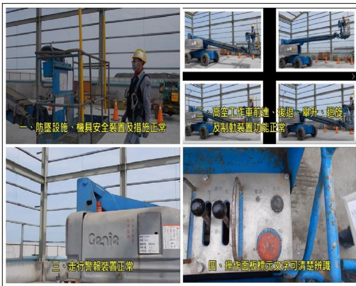
圖 2 高空工作車安全性確認
