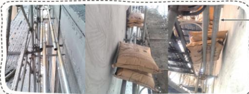
現場實際安裝「鍍鋅鋼管+延伸拖架」，經試測後無變形。(開口間距10-15cm)
