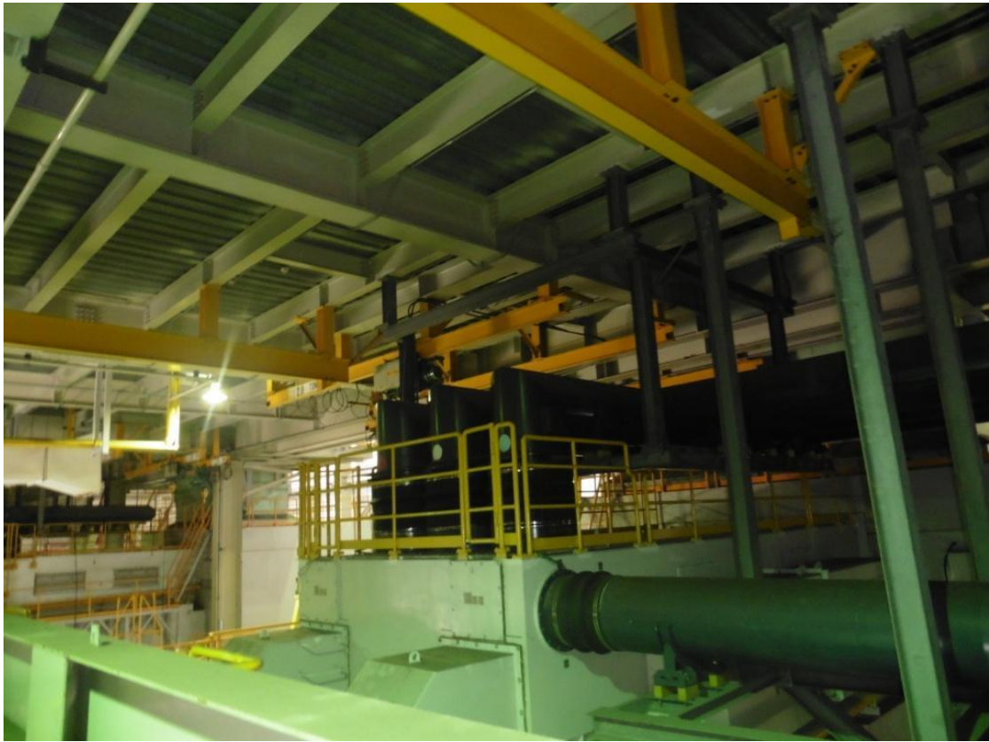
在機台上方及作業區四周加裝護欄
