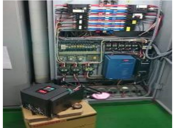
圖 2 設置控制馬達轉速之變頻器
