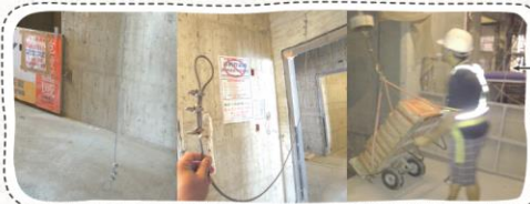
鋼索方式移動性大，且可避免人員於開口處作業時使用安全帶過短現象。
