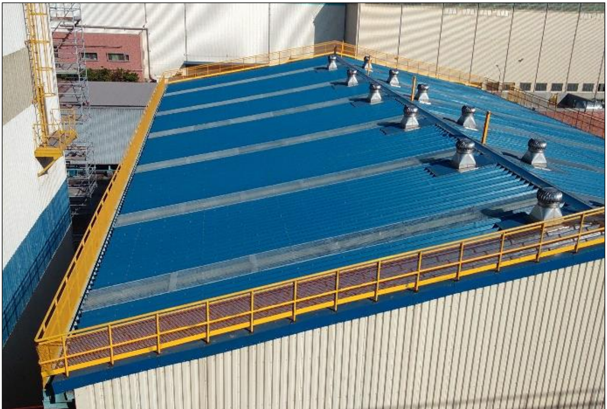
圖 3 屋面安全性提升完成照片。
