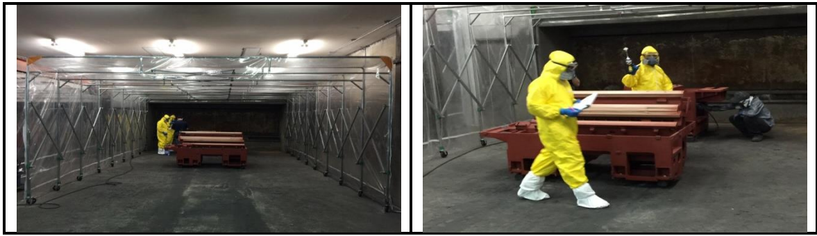
圖 3 通風工程改善後，裝設活動伸縮式棚架，PID 量測現況
