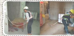
舊有：電梯直井開口處牆面設置安全扣環(上左圖) 作法：提供緩降安全母索供吊料人員使用(上右圖)
