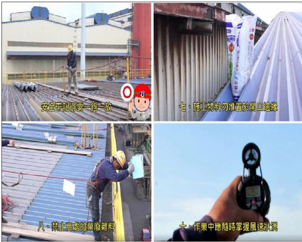
圖 6 屋面作業危害防止影片-施工注意事項
