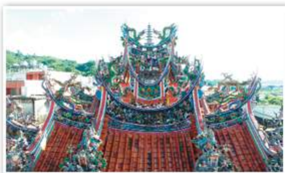
▲中崙保安宮屋頂
