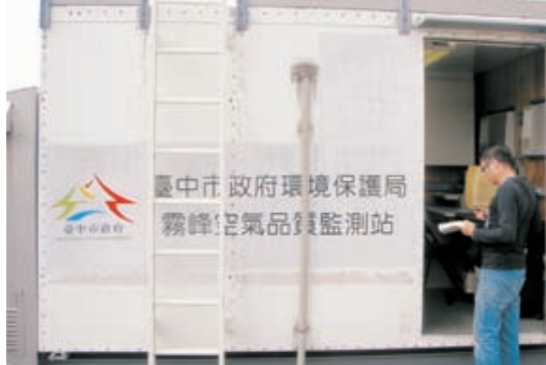
台中市環保局在台電霧峰服務處頂樓設置空氣品質自動監測站。
