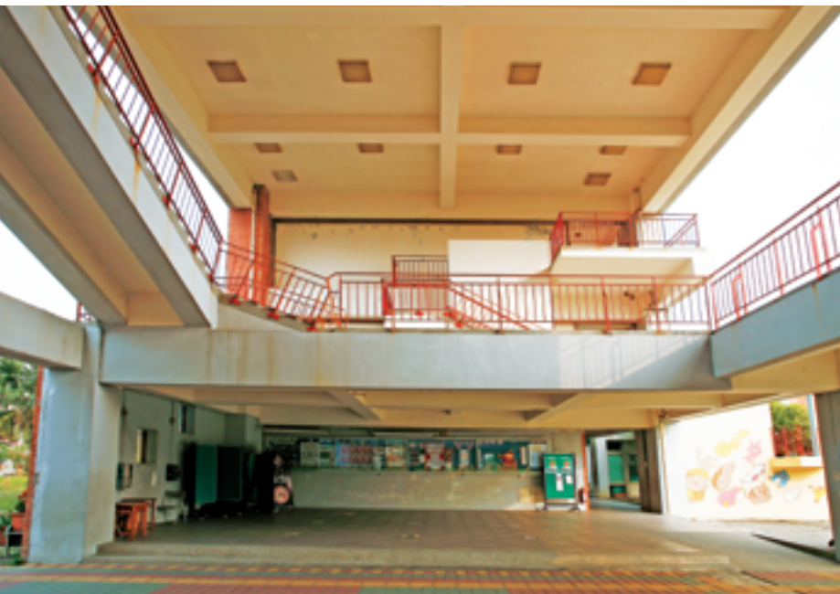
銜接建築間的廣大平屋頂，形成半戶外的活動空間。
