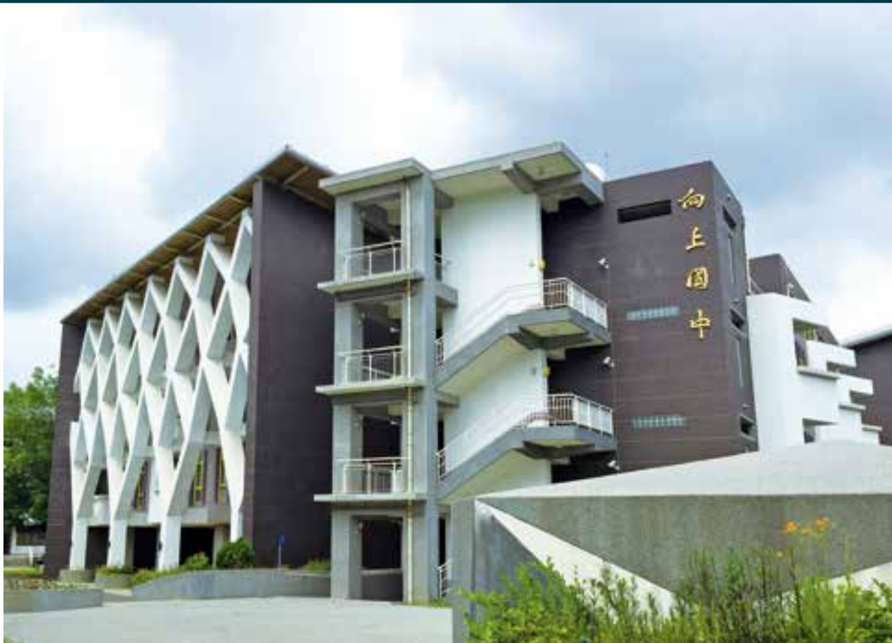
向上國中的向欣樓是姜樂靜建築師精心打造的新校舍。
