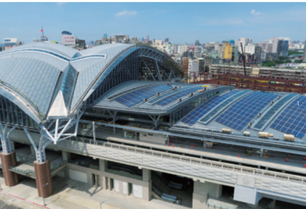
1. 高架化的新站外型就像大鵬展翅，彎曲造型的大型遮棚，上緣細心加設玻璃垂幕，減少雨水潑進月台。2. 月台上的柱列上端採樹枝狀造型的柱頭，屋頂採條狀天窗，以自然採光降低耗能。3. 站內空間採輕巧而具規律美感的天花板。
