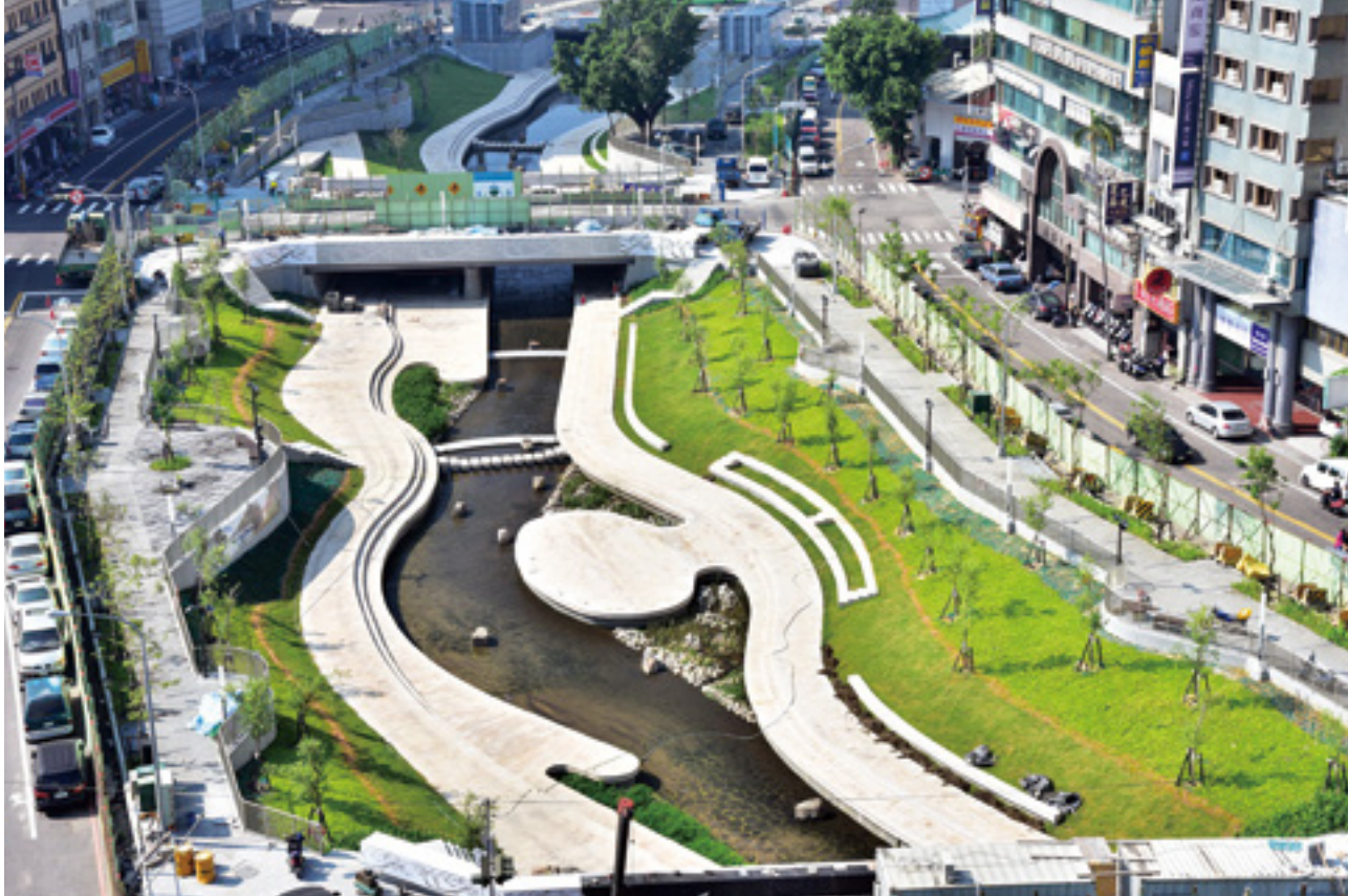
柳川整治工程將兩旁車道部分縮減，原混凝土護岸向兩側各拓寬 8 公尺，還地於河。
