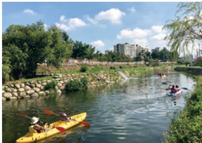
早溪在「康橋計畫」推動下，成為從事水上運動的新興景點，接下來的「大康橋計畫」，將讓早溪整治朝上、下游延伸。
