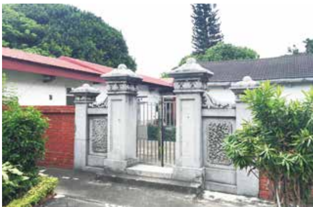
東勢仔勝昌堂的大門入口洗石子作工精美，立柱雕刻完整。
