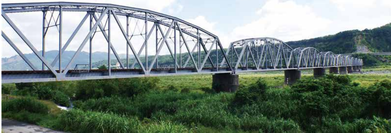
大安溪鐵橋是目前全臺鐵道僅存的三座花梁鋼橋之一
